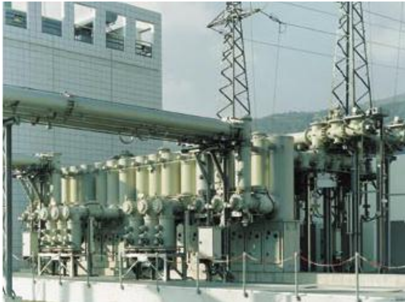
Figura 10: Disjuntores a SF 6 (245 kV) – França.
